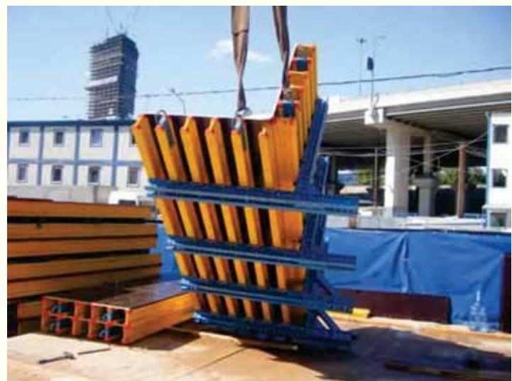
Ayarlanabilir Kolon Kalıp Sistemi, 20/20 ile 70/70 arasındaki kolonlar için 115 cm uzunluğundaki ayarlanabilir kuşak ile 70/70 ile 100/100 arasındaki kolonlar için ise 145 cm uzunluğundaki ayarlanabilir kuşak ile oluşturulur.
