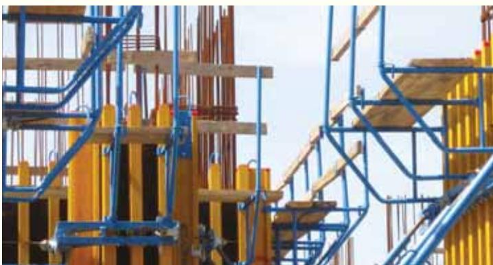
İŞ-KA Ahşap Kırışlı Kalıp Sistemi, endüstriyel yapılar, alt yapı inşaatları, okul ve konut inşaatları ve çeşitli istinat perdeleri gibi geniş bir alanda perde ve kolon kalıbı olarak kullanılır. Plywood, H20 ahşap kırış ve çelik kuşak olmak üzere 3 ana eleman ile panolar oluşturulur.
